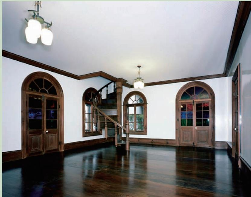
1階はアーチ中央に要石形の束を、下に彫刻の持送をつけ、ベランダ柱間は円形断面の繰形をもつ手摺を設けている。内部は1階南室が洋風で、壁面は漆喰の磨き仕上げ、天井を布張りにし、この室の西南隅に2階に昇る大胆な構造の木製螺旋階段が設けられている。木製螺旋階段は、柱以外は総松造りで、1本の柱に各段の踏板・蹴込板が組み込まれ、最上下段以外は宙に浮いたような造りになっている。仕口には精緻な加工が施され、手摺のねじれ加工も計算されたもので、組み付けは堅固、仕上げにいたるまで丁寧な仕事が窺える。北側の6畳2室は和風で各間とも床の間と押入を構え、東側に半間の階段室を設けている。玄関正面および背面と1階ベランダの出入口扉と欄間に赤・緑・黄朱・青紫の色ガラスを嵌め込んでいる。1階の窓は両開き、外側に鎧戸を釣り込み、上部は半円形のガラス欄間とする。
